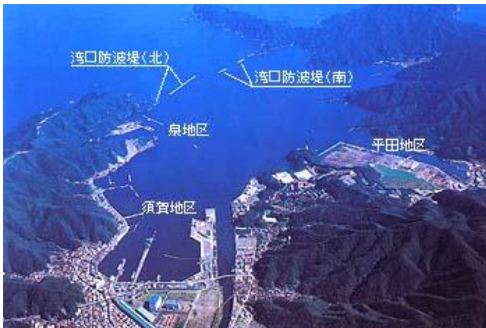
国交省 HP より引用：破壊前の防波堤
