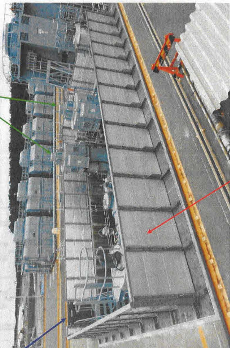
高さ1.5mの防水壁(金属製パネル)を設置
