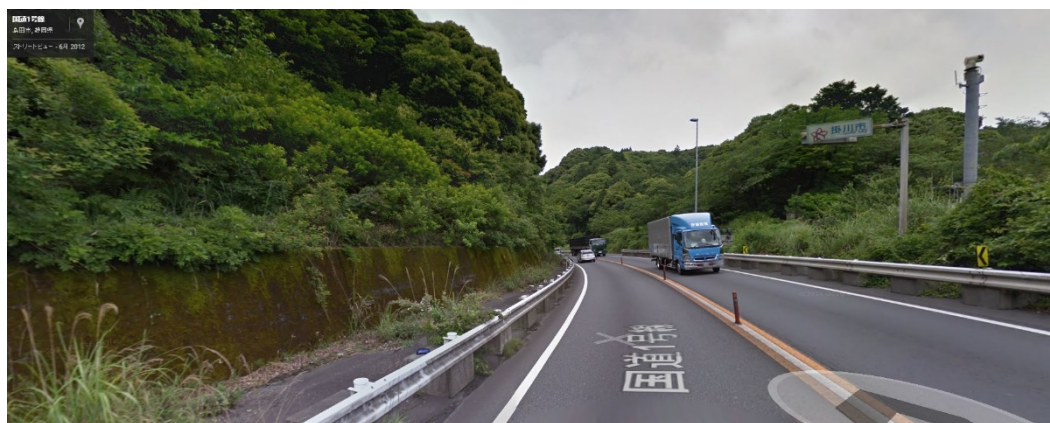
国道1号線バイパス・掛川
